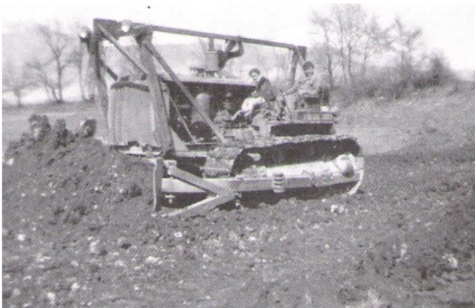
Gradnja nogometnega igrišča v Lescah, 1946
