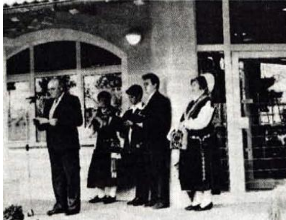
Otvoritev nove pošte – 4275 Begunje
