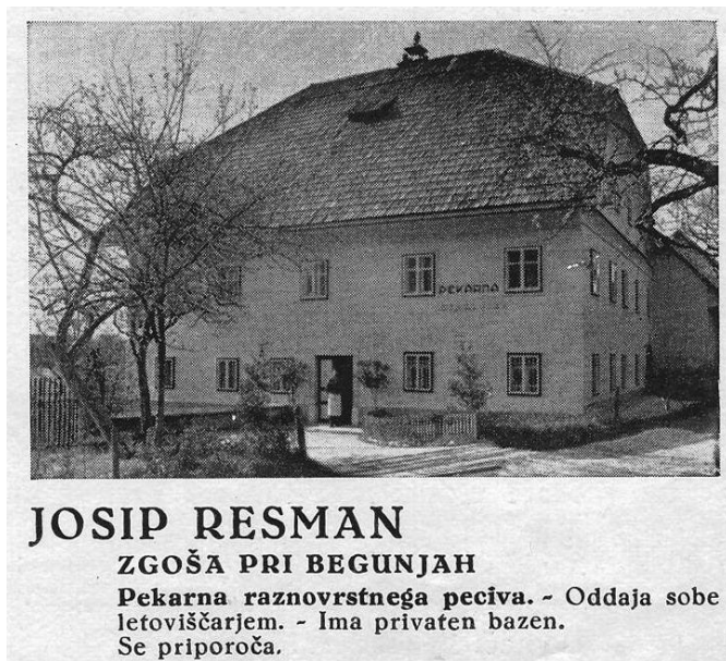
Pekarna – Josip Resman, ok. 1930 Vir: DAR (Letovišče Begunje pri Bledu – Dravska banovina)
