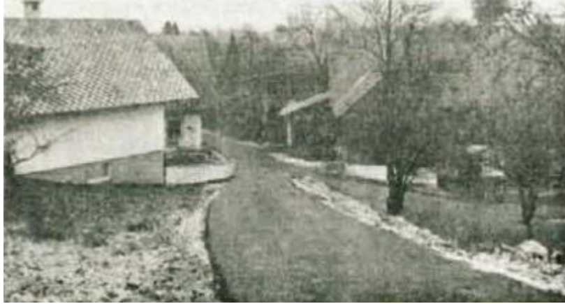
Prvi asfalt na Ravnici
