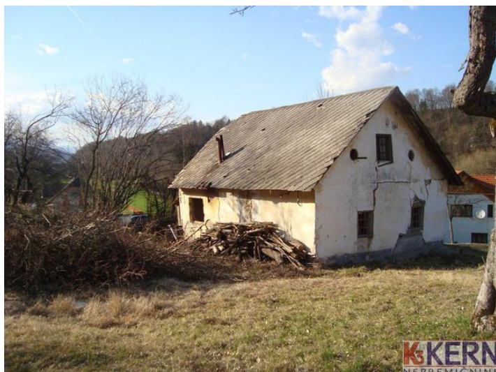
Hiša – zgrajena 1937 Vir: k2kern.nepremicnine
