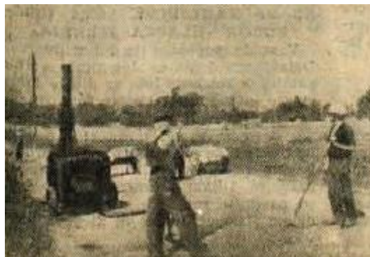
Asfaltiranje ceste v Hlebcah, 1957
