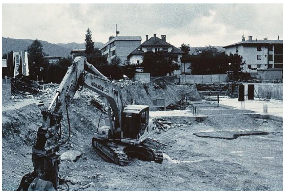
Izkop jame za novo knjižnico Vir: Foto društvo Radovljica (foto Ivan Pipan)
