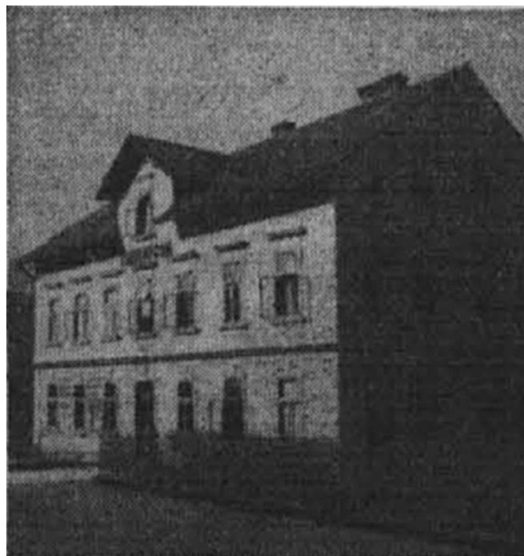
Stavba pred prezidavo, 1941
