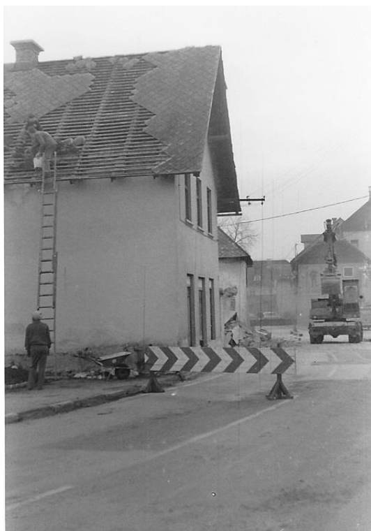
Začetek rušenja glavnega objekta, pomlad 1984 Vir: foto Franci Valant, p. d. Benč
