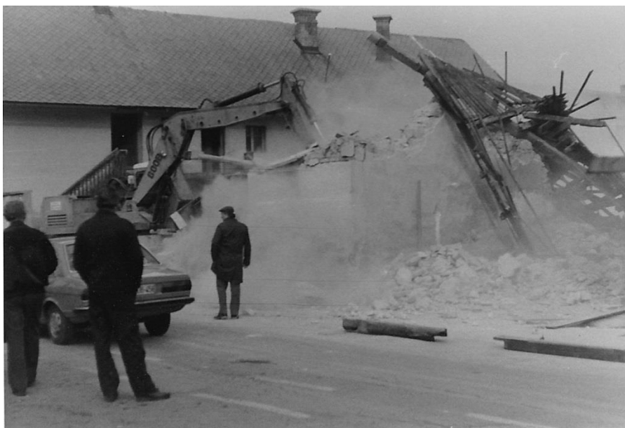
Rušenje desnega objekta – zadaj glavna stavba, pomlad 1984 Vir: foto Franci Valant, p. d. Benč
