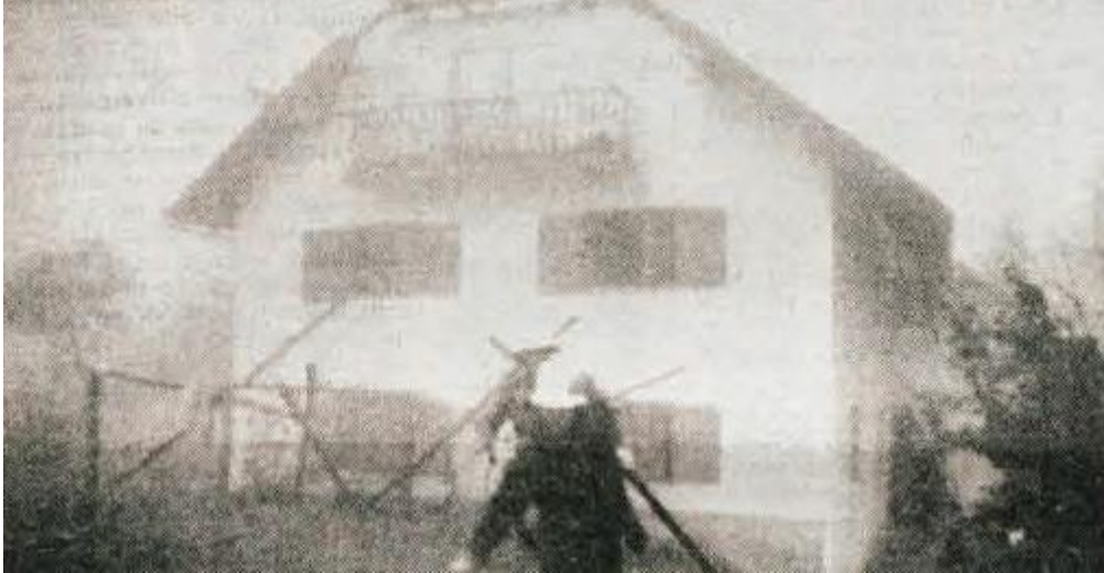
Požar na Zg. Dobravi
