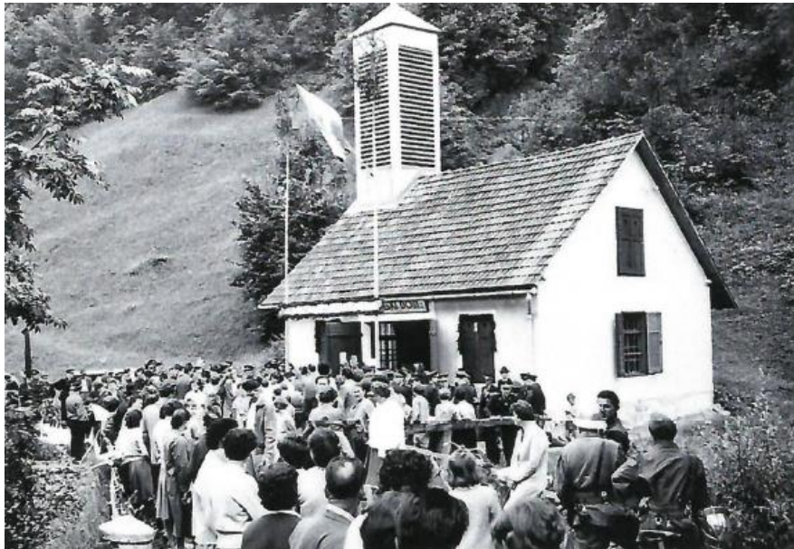
Obnovljen gasilski dom in stolp za sušenje cevi, 1959 Vir: 20 let GZR
